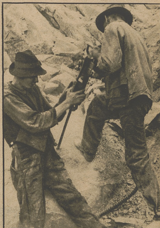
Przy wtórze przeraźliwego zgrzytu, świder młotowej wiertarki nawierca otwór dla dynamitowego ładunku.
