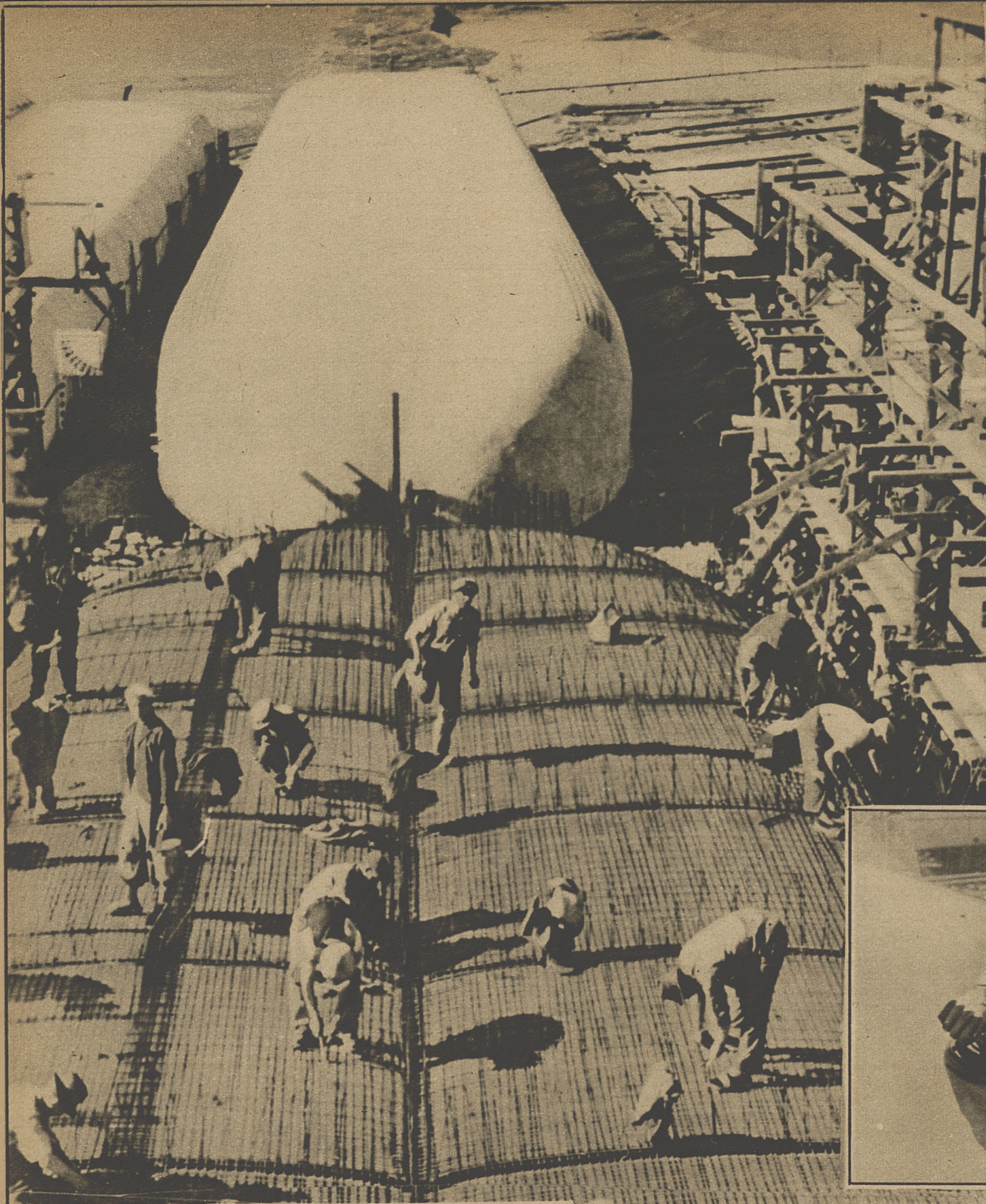
wyżej: Na przedniej części ilustracji widzimy żelazną konstrukcję statku, która będzie „zalana” betonem; w tylnej części statek gotowy do spuszczenia na wodę.
