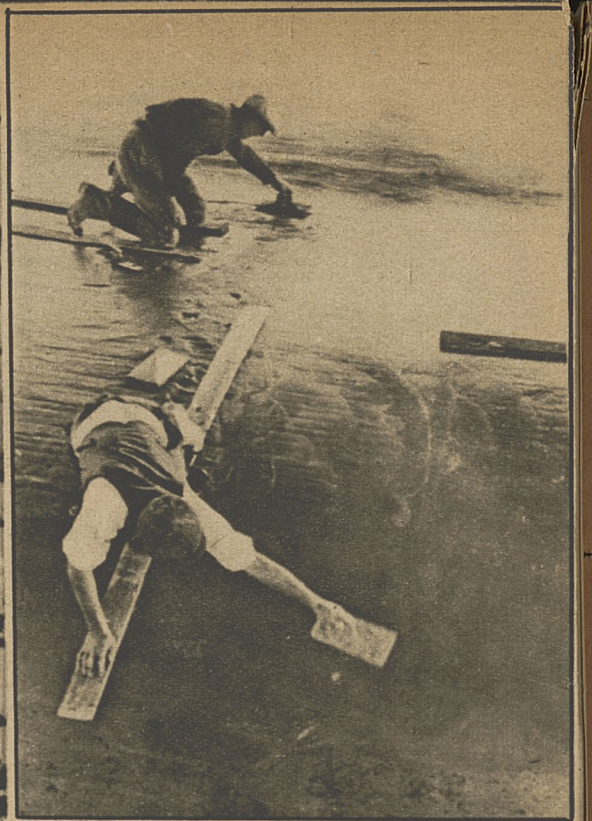
Powyżej: Budowa statku jest tutaj zwyczajną robotą murarską. Murarze wygładzają powierzchnię statku.
