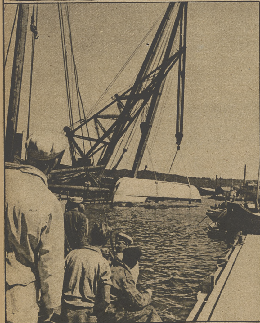
Statek budowany jest dnem do góry i tak też jest spuszczaany na wodę po ukończeniu. Dopiero na wodzie musi być odwrócony do normalnego położenia.
