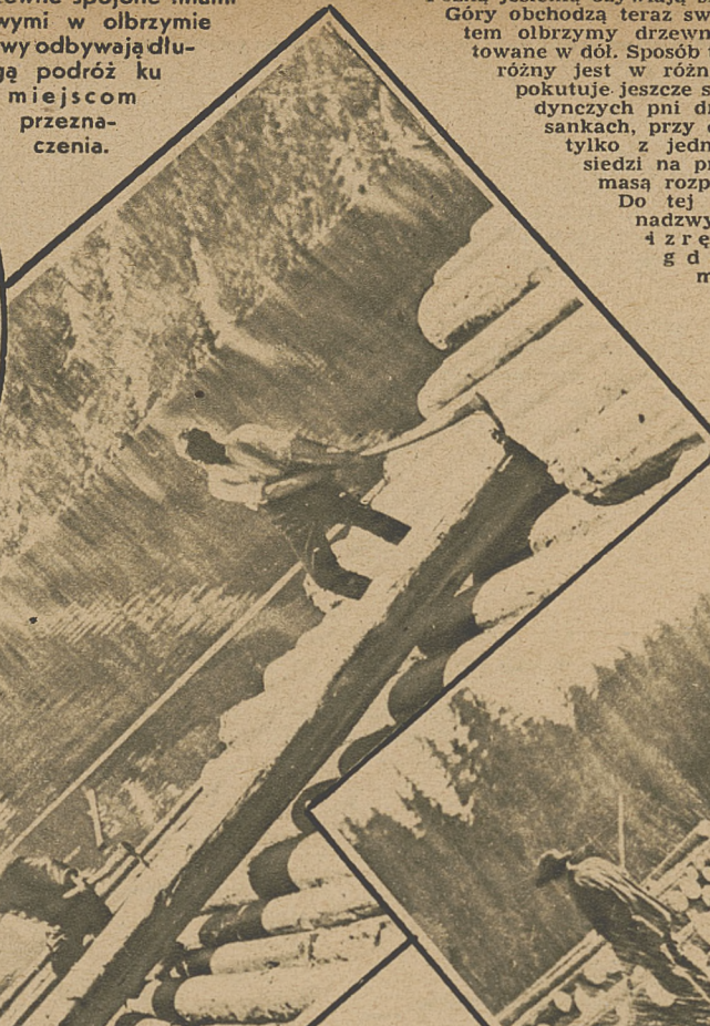
ostrożność grozi powożącemu ciężkim kalectwem lub na wet śmiercią. Mistrzami w tej karkołomnej jeździe są bawarscy robotnicy leśni. Szybszym i bezpieczniejszym sposobem spuszczenia drzewa z gór jest stosowanie rynien zbudowanych z silnych grubych desek, po których drzewo wypuszczone z miejsca „startu” na górze mknie w dół jak lawina. Pędzące z szybkością często ponad 100 km na godzinę olbrzymie pnie drzewne po stromym stoku górskim, ujęte w tor nadający im kierunek, spadają w jezioro, gdyż tylko woda jest w stanie zahamować pęd tych olbrzymów. Krótkie pnie zrzucane z prostopadłej ściany górskiej z wysokości 200 metrów wprost w jezioro. Obecnie transport drzewa odbywa się przeważnie na drodze mechanicznej, za pomocą specjalnych kolejek linowych.
