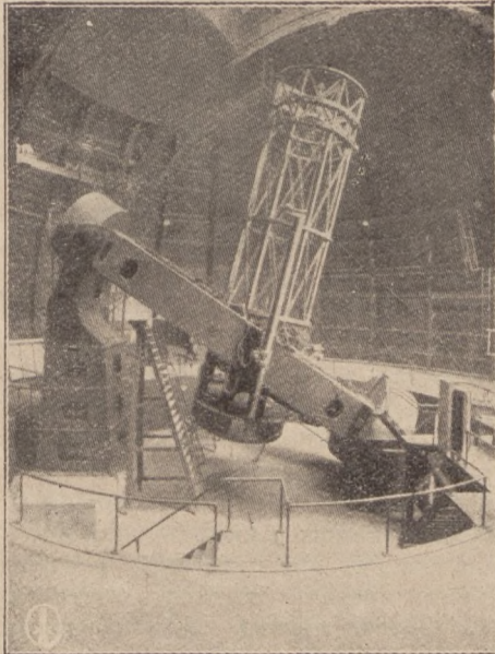
Черт. 3.—Телескопъ Гукера обсерваторіи на горѣ Вильсонъ съ зеркаломъ въ 2\frac{1}{2} метра діаметра, помощью котораго впервые измѣрены поперечники звѣздъ.
