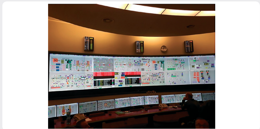
Fot. 2. Fragment nowoczesnej nastawni systemu DCS MASTER z implementacją ściany graficznej
