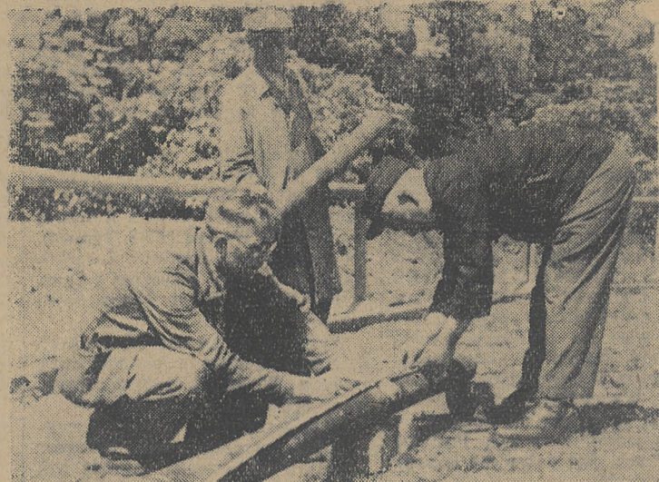
Majster Ulfik — szef »sportowej« brzygady spawa rury do ogrodzenia boiska ZKS Metal.
