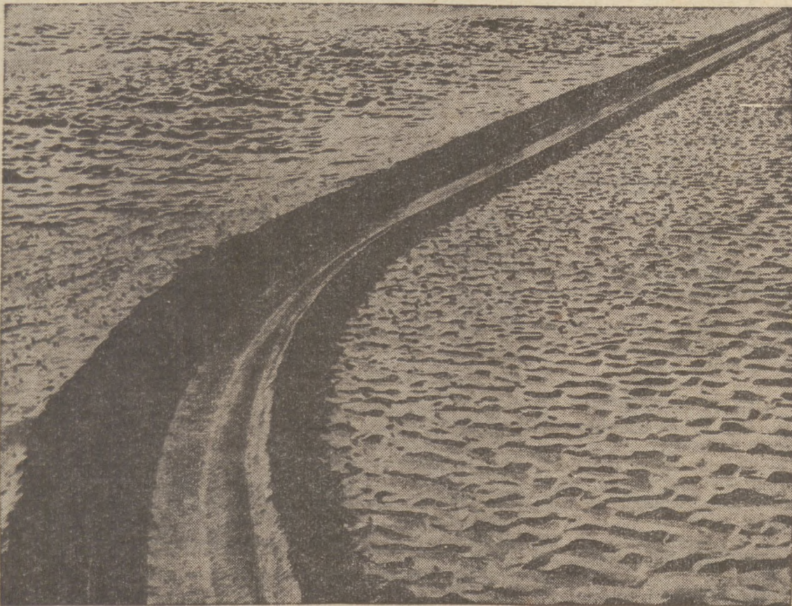
Zdjęcie z samolotu, nowobudowanego kanału All-American w pustyni Kalifornijskiej, nad granicą Meksyku, który będzie służył do nawodnienia okolicznych piaszków.
