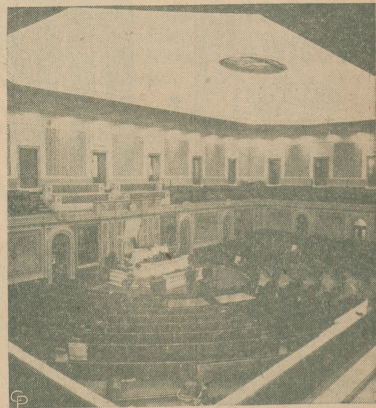
Izba reprezentantów po raz pierwszy odrestaurowana od 1857 roku są ozdobione pięknymi ornamentacjami, a stalowy sufit zastąpił dawne stalowe wężadła.
