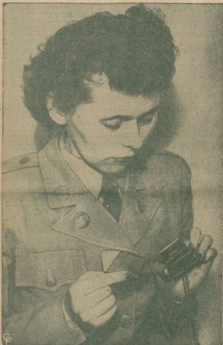
PRZYRZĄD DO BADANIA PROMIENI RADIOAKTYWNYCH. — Kapral Doris J. Apgar ogląda nowy przyrząd, który użyty może być do badania promieni radioaktywnych. Przyrząd ten na taśmie rekorduje jak silne są promienie radioaktywne, na terenie w jakim znajduje się osoba zaopatrzona w taki przyrząd.
