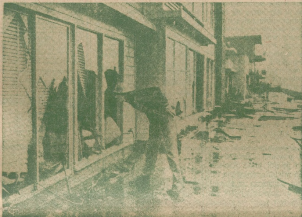
PO PRZEJŚCIU HURAGANOWEJ BURZY W KALIFORNII. — Huraganowe burze, połączone z gwałtownymi deszczami nawiedziły ostatnio całe wybrzeże Kalifornii nad Pacyfikiem, wyrządzając w miejscowościach przybrzeżnych olbrzymie szkody. Oto widok zniszczonych wystaw sklepowych w miejscowości Rio Del Mar.
