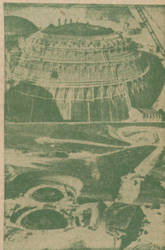
BUDOWA BAZY POCISKÓW RAKIETOWYCH TYTAN. — Korpus Saperów buduje obecnie potężną bazę i wyrzutnię dla pocisków rakietowych o dalekim zasięgu, Tytan. Baza powstaje w pobliżu Denver, Colo. U góry—szkielet rusztowań zalewanych cementem. U dołu widok ogólny rejonu bazy. Po dokończeniu prace wszystkie zostanie zasypane ziemią, zrównane z powierzchnią, pozostaną widoczne tylko drogi dojazdowe.
