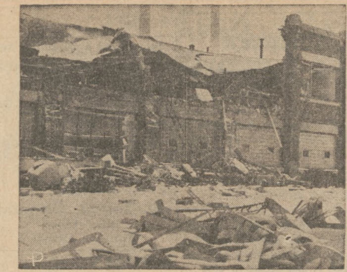
WYBUCH W LABORATORIUM W EAST CHICAGO. W East Chicago, Ind., w budynku firmy St. Clair Oil Co. nastąpiła gwałtowna eksplozja w laboratorium. Wybuch poważnie uszkodził cały budynek, gdzie laboratorium się znajdowało. Dwóch chemików zostało zabitych, 7 osób rannych. Przyczyna wybuchu pozostaje wciąż nierozpoznana.
