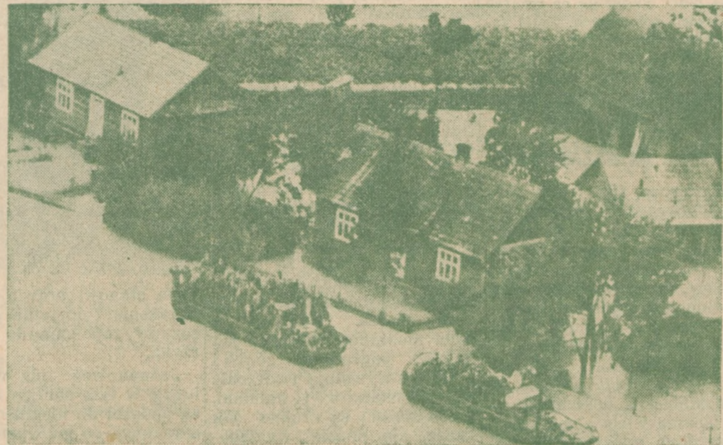
OBRAZEK Z POWODZI W POLSCE. — Z Polski dochodzą wiadomości o dotkliwej klęsce powodzi, jaka nawiedziła przed kilku dniami zwłaszcza południową część kraju. W wielu miejscach nadbrzeżne tamy przy rzekach Wiśle i Odrze zostały przerwane a woda wylała szeroko, zagrażając mieszkańcom okolicznych wiosek. — Oto scena ewakuowania ludności z jednej z zagrożonych wiosek nad rzeką Dunajcem. W ostatnich dwóch dniach sytuacja podobno się nieco poprawiła.
