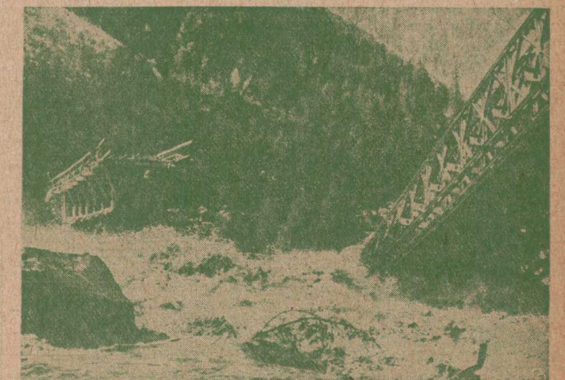
POWÓDZ W AUSTRIACKICH ALPACH. — W Alpach Austriackich panuje powódź spowodowana gwałtownymi deszczami. Na zdjęciu widac zniszczony most im. Ferdynanda na rzece Oetz.
