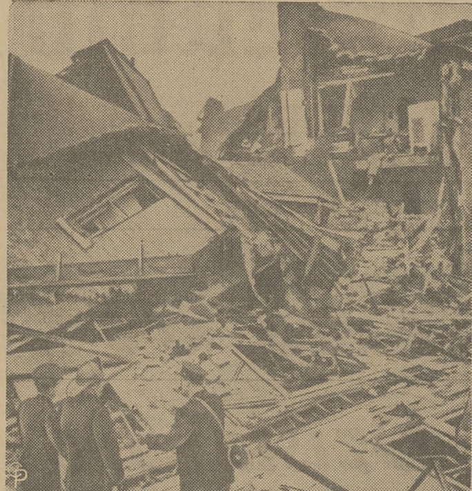
WYBUCH OD ULATNIAJĄCEGO SIĘ GAZU. — W Detroit, w stanie Michigan eksplozja — przypuszczalnie od ulatniającego się gazu — zrujnowała niemal z ziemią duży budynek apartamentowy. Wiadomości o zabitach niema, lecz jest stwierdzonych wiele osób rannych. Zdjęcie przedstawia dom ten — po wybuchu.
