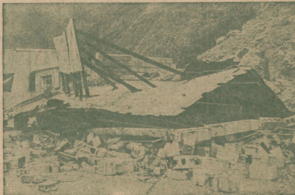
ULEWY I POWÓDZ podmyła skały i w Chhattanooga, Tenn., które obsunęły się i zwały budynki, niszcząc życie i dobytek ludzi.
