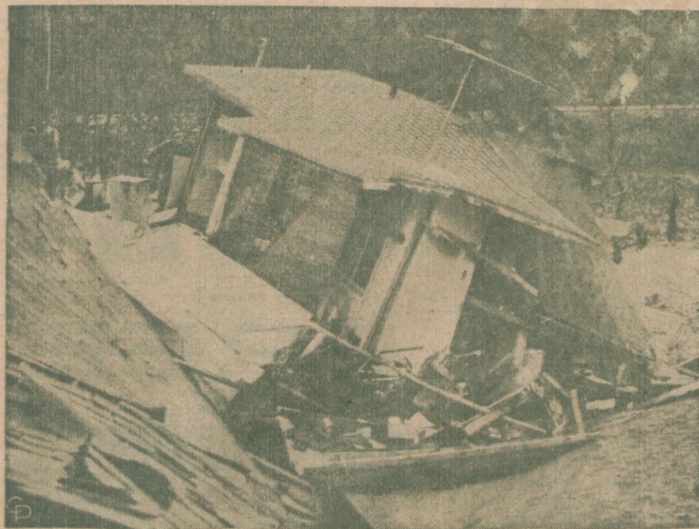
WIELE TAKICH ZRUJNOWANYCH i wyrzuconych przez wodę domów można znaleźć wzdłuż rzeki Rogue, Ore. po katastrofalnym jej wylewie.
