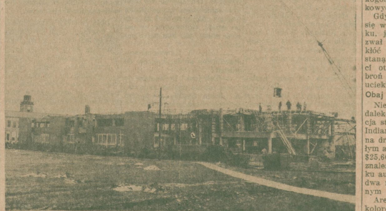
Praca nad budową Gmachu Wiedzy (Science Bldg.) na kampusie Kolegium Związkowego w Cambridge Springs, Pa., postępuje szybko naprzód, jak widzimy powyżej na fotografii dokonanej w dn. 29-go listopada, 1965 roku. Budynek ma być wykonany w lecie r. 1966 i ma być gotowy na rozpoczęcie roku szkolnego. Koszta pobudowania Gmachu Wiedzy wynosić będą około jeden milion, trzysta tysięcy dolarów.
