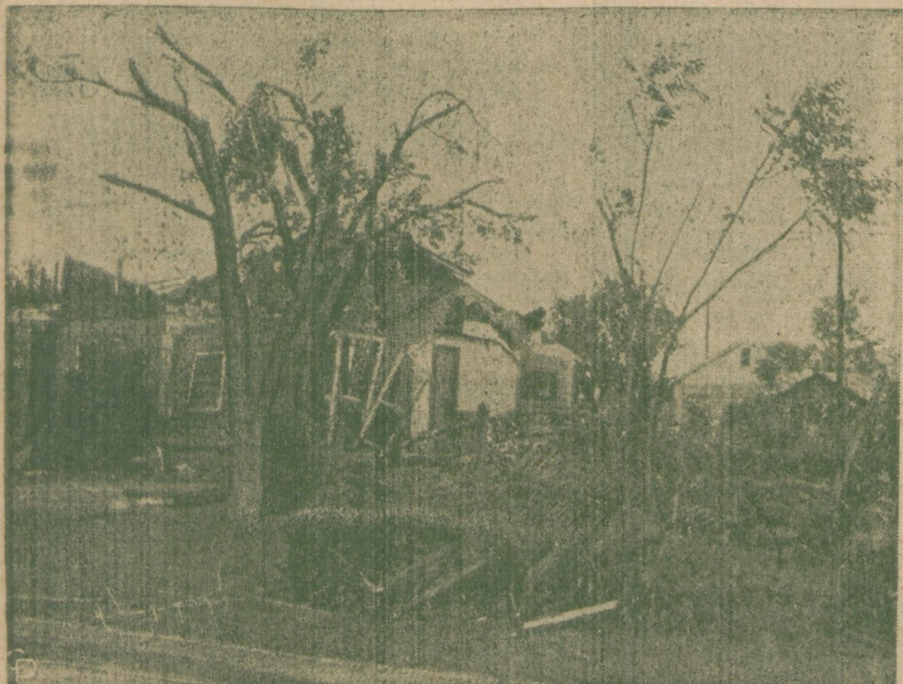
SKUTKI HURAGANU — Tak wygląda część 66 bloków znajdujących się na północno-wschodniej części miasta Enid, Oklahoma.
