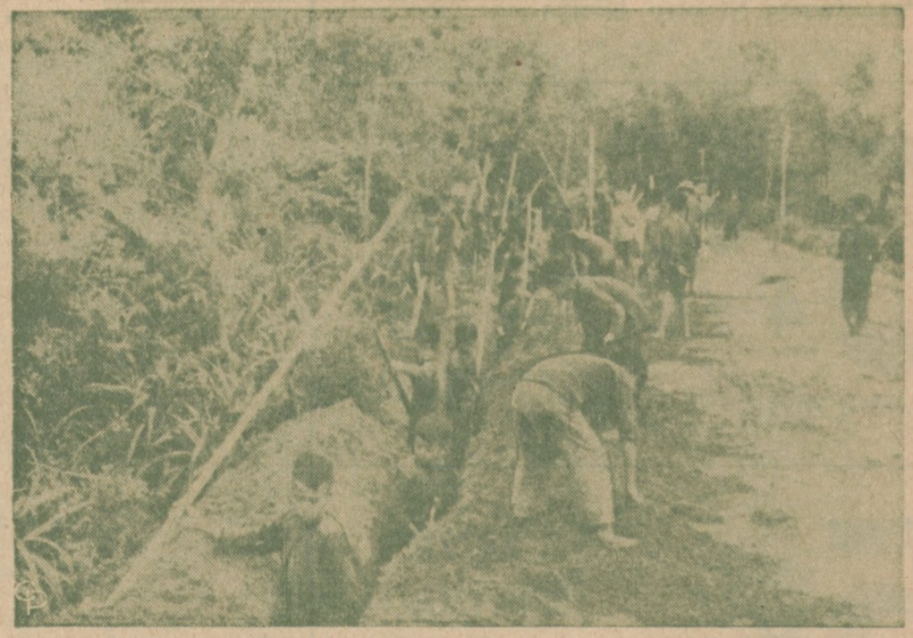
W HAIPHONG, GŁÓWNYM PORTCIE Północnego Wietnamu, jak wynika ze zdjęcia opublikowanego w Warszawie, zaprzężono dzieci do pracy przy kopaniu rowów przeciwlicznych.
