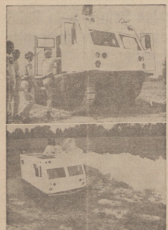
SPECJALNY POJAZD MECHANICZNY — dla policji, tłumiącej rozruchy zademonstrowano w Fairfax, Va. Jest to auto pancerne, które mieści 15 policjantów i jest uzbrojone w urządzenia dla rozpraszania pozornych gazów, oraz dwie maszyny do gaszenia pożarów.
