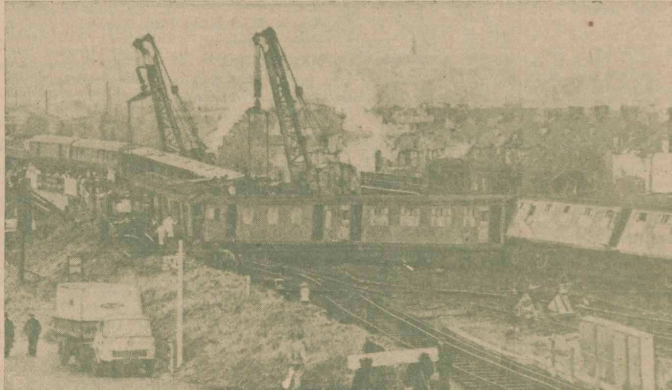
OCZYSZCZANIE SZYN PO KATASTROFIE KOLEJOWEJ — Ruchome dźwigi oczyszczają szyny w Hither Green, na południowy wschód od Londynu, po wykolejeniu się 11-tu wagonów pędzącego pociągu osobowego, kursującego pomiędzy Hastings i Londynem, i stoczeniu
