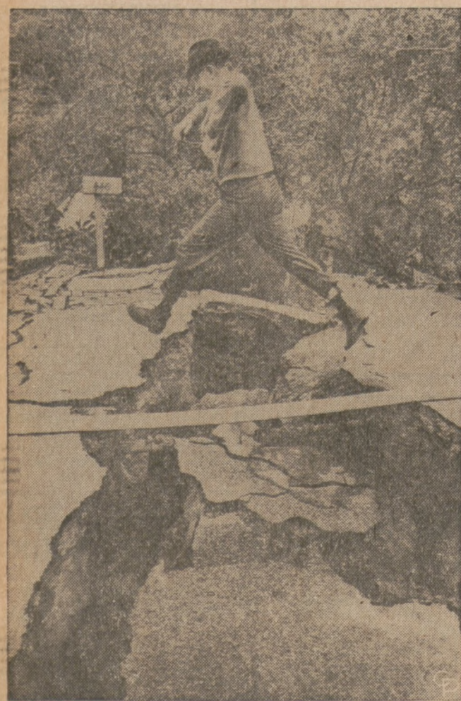
SKUTKI OBSUNIĘCIA SIĘ ZIEMI — Miejski urzędnik przekazuje jedno z wielu wgnębień, które powstały w Highland Parku na obszarze Los Angeles. Obsunięcie się ziemi zmusiło władze do ewakuacji ludności z ośmiu domów na tym obszarze.
