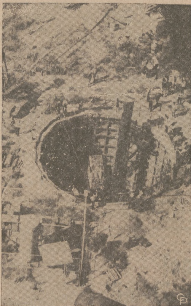
SMIERĆ 17-TU GÓRNIKÓW — Ekipa ratownicza poszukiwała ciał 17-tu górników, którzy ponieśli śmierć wskutek eksplozji gazowej w szybie wodnego tunelu (na zdjęciu) w Sylmar, Calif. Tunel znajduje się w odległości 15-tu mil od śródmieścia Los Angeles.
