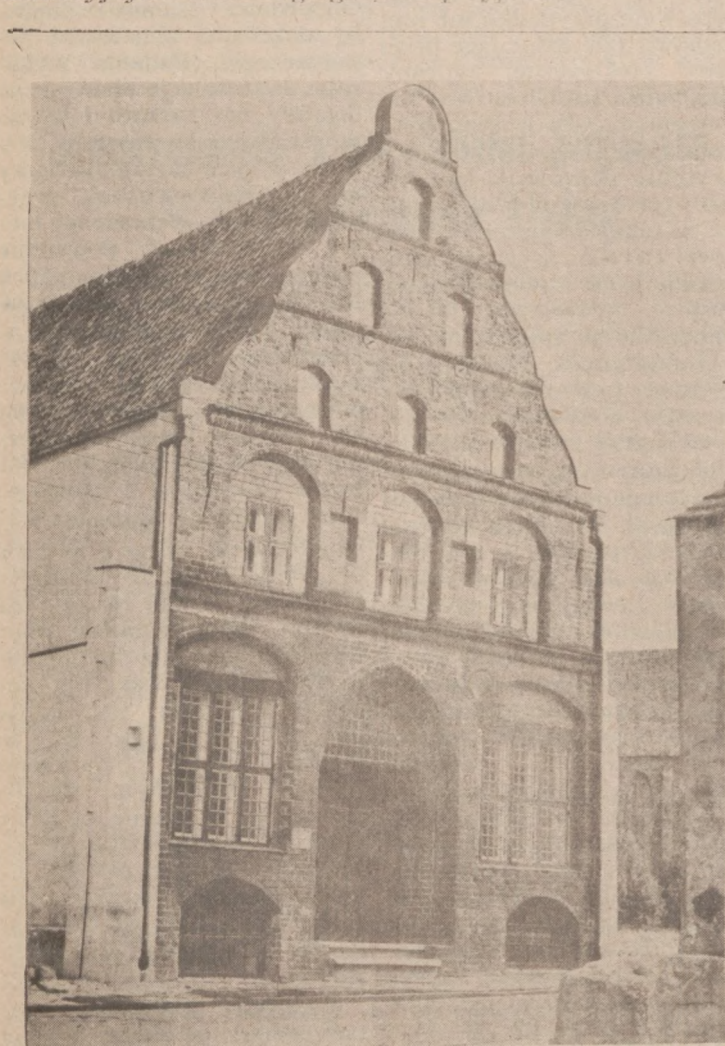
Kołobrzeg. — W ostatniej fazie II wojny światowej miasto i port niemal w całości legły w gruzach. Zniszczenia przekroczyły 90% zabudowy miejskiej. Do kilku szczęśliwie ocalałych budowli zabytkowych należy tzw. kamienica Schlieffenów (na zdjęciu), w pierwotnym XIV-wiecznym założeniu gotyckim, lecz później, w XVII wieku przebudowana.
