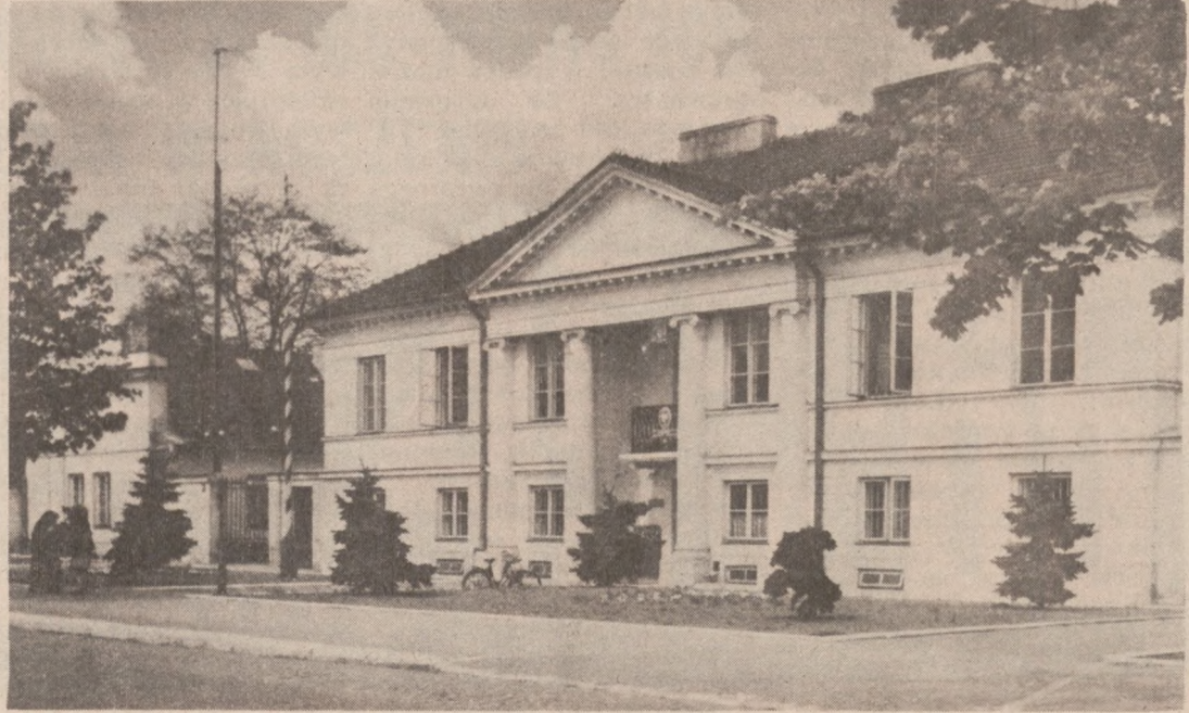
Jednym z wielu zabytkowych obiektów w Łowiczu jest zespół klasycystycznych budynków dawniej poczty konnej, wzniesionej w 1829 r. W 1939 r. wszystkie te zabudowania splonęły od bomb niemieckich. Po wojnie zrekonstruowano zarówno gmach główny (na zdjęciu), jak i część przyległych do niego stajni i wozowni.
