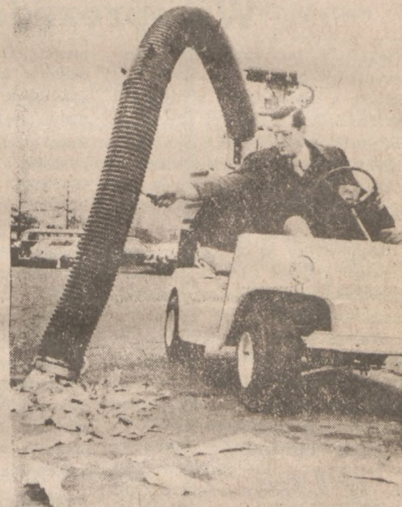
WASHINGTON, D.C. — John Hoke z systemu parków w Washingtonie, demonstruje mały samochód elektryczny, który pracuje też jako odkurzacz. Dołączona rura wchłania śmiecie w parkach.
