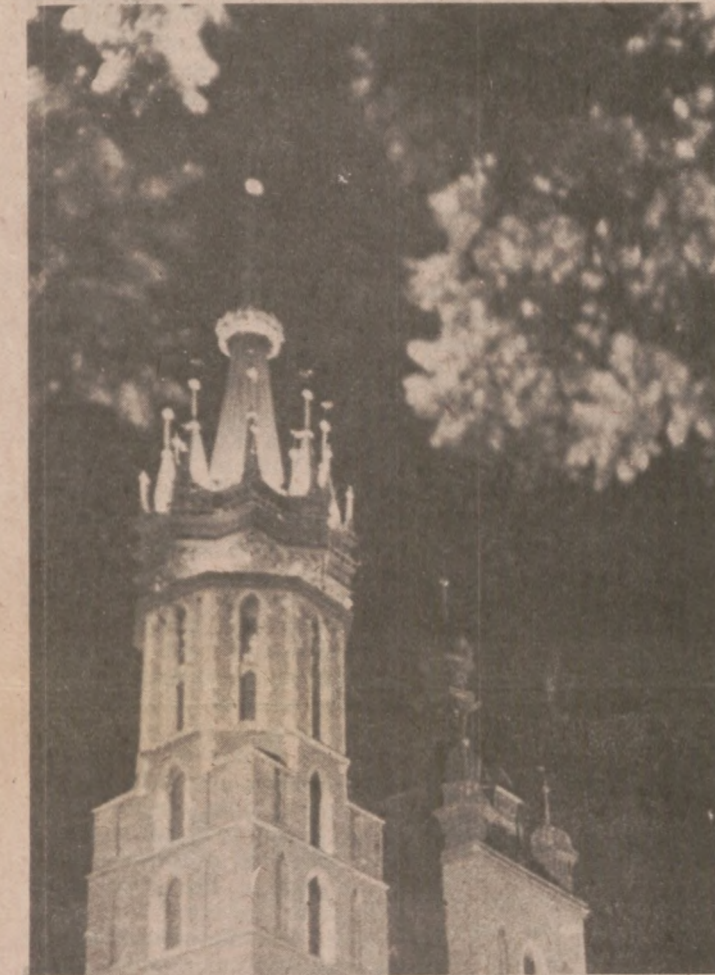
Wyższa wieża kościoła Mariackiego w Krakowie o wysokości przeszło 80 metrów należy do najpiękniejszych gotyckich rozwiązań architektonicznych w Polsce. W dolnej partii wieża ma charakter kwadratowy, w górnej — sześcioboczny, a w najwyższej — ośmioboczny. Wieża ta od początku spełniała funkcje strażnicy miejskiej. Obecnie co godzinę strażnik gra z niej na cztery strony świata sławny hejnał krakowski.
