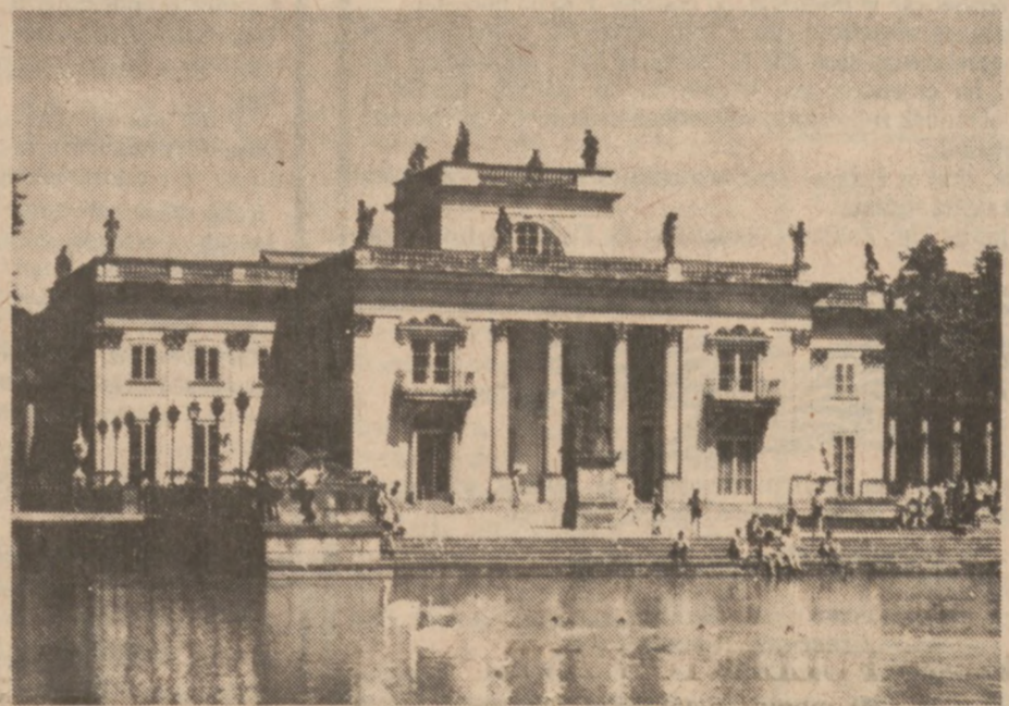
Patac w Łazienkach — Warszawa
