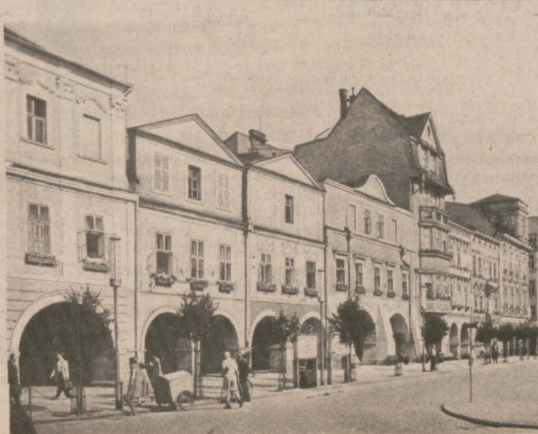
CIESZYN — Kamienice z podcieniami w Rynku.
