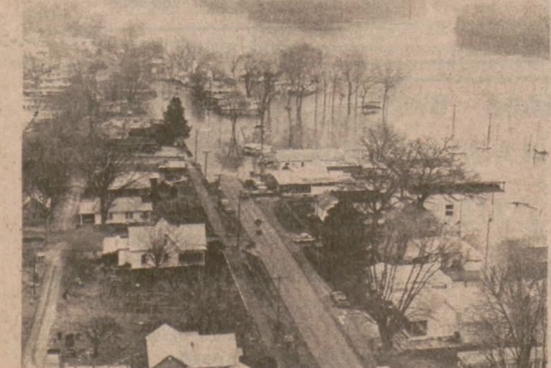
GRAFTON, ILL. — Wysoki poziom wody w rzekach Mississippi i Illinois zmusił mieszkańców do opuszczenia wielu domów wzdłuż Great River Road. (UPI)
