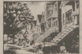
Schody w Avondale
