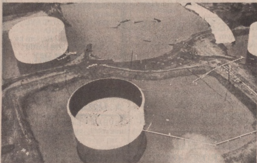
JEFFERSON — Z tych zbiorników niedaleko Pittsburgha wyciekło ponad 3 mln galonów ropy, z czego olbrzymia część dostała się do pobliskiej rzeki Monongahela. Trwa akcja usuwania skutków katastrofy. (UPI)
