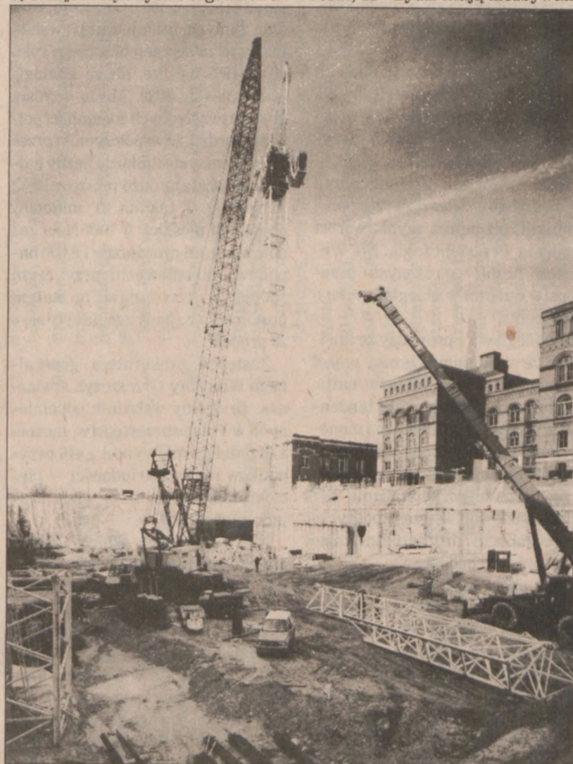
Na placu budowy Muzeum Holocaustu olbrzymi dźwig. Pozostanie tam przez około 1.5 roku. Foto: Alan Giebert
