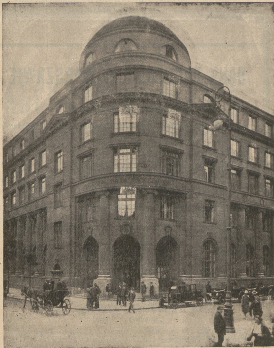
Fronton gmachu centrali Pocztowej Kasy Oszczędności w Warszawie. The building of the Postal Savings Bank in Warsaw.
