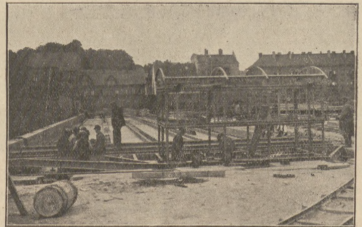
Montaż przesuwalni elektrycznej w porcie Tczewskim.
