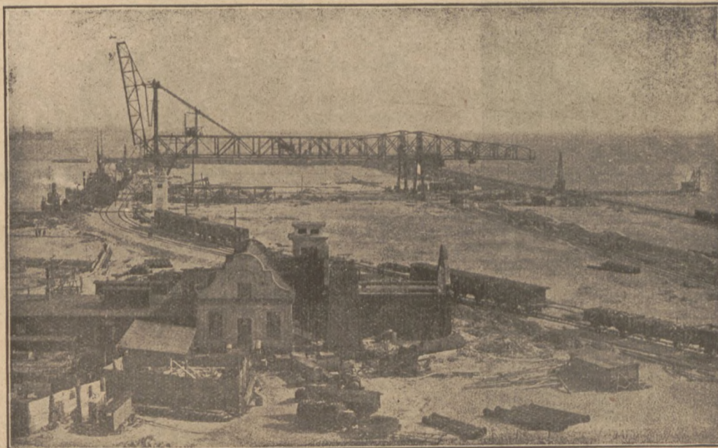
Krany przeładunkowe w porcie w Gdyni.
