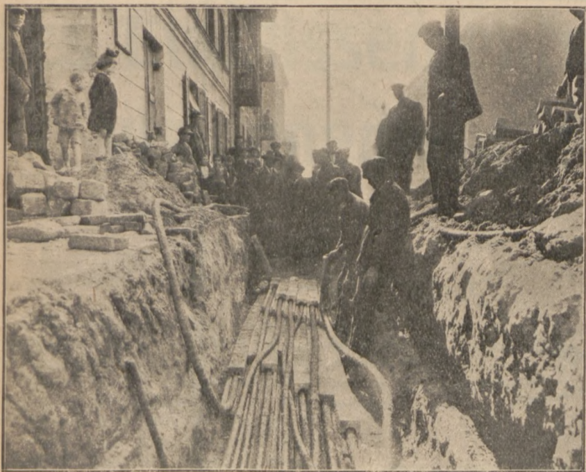
Pose des cables.
