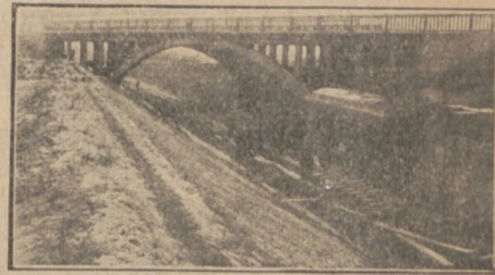
Żelazo - betonowy wiadukt drogowy nad linią Zgierz — Kutno.
