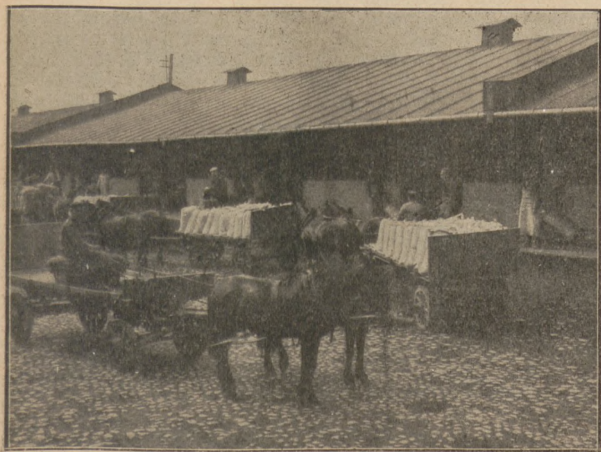
Déchargement des marchandises du dépôt.
