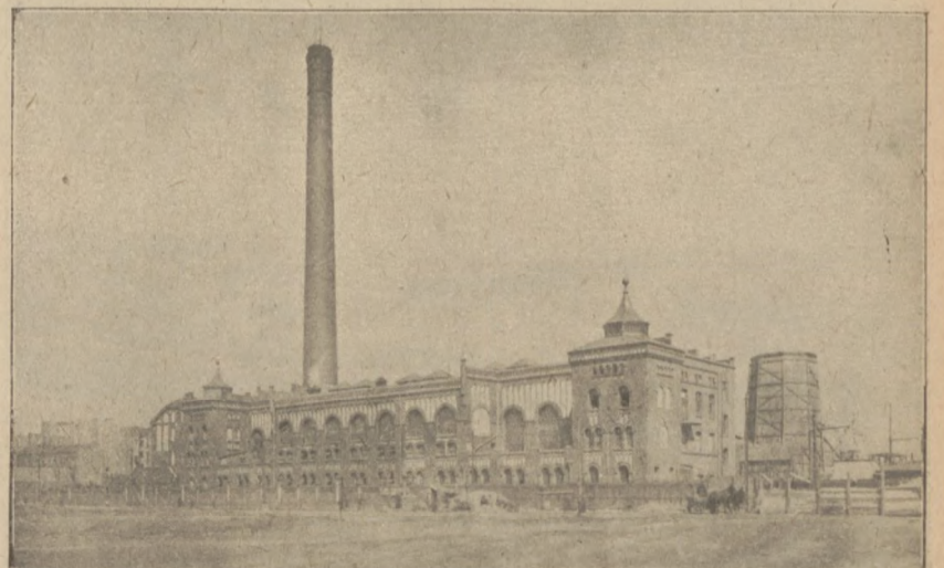
Usine d'Électricité de Varsovie.
