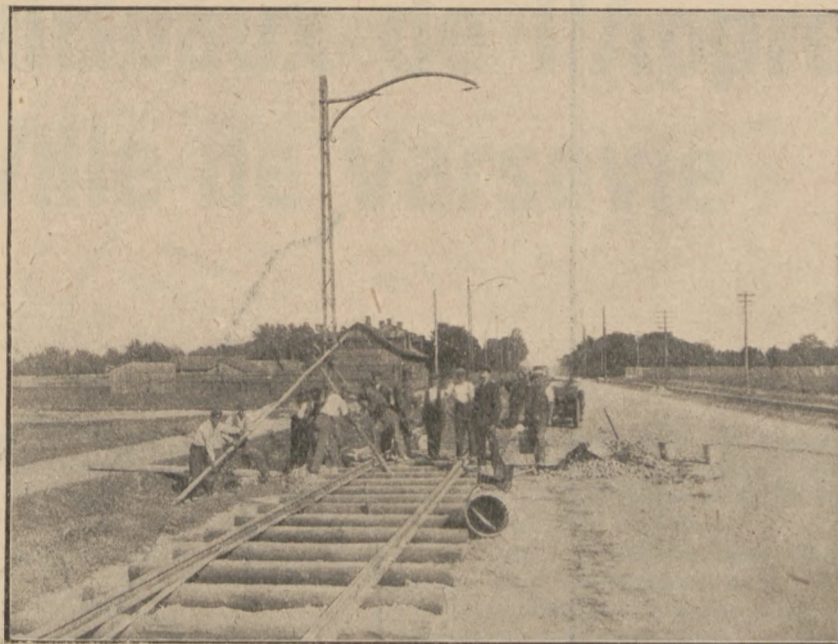
Construction d'une nouvelle voie électrique.
