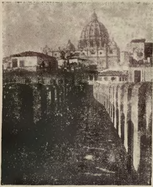
Odrestaurowane obecnie przejście z Zamku do Watykanu
