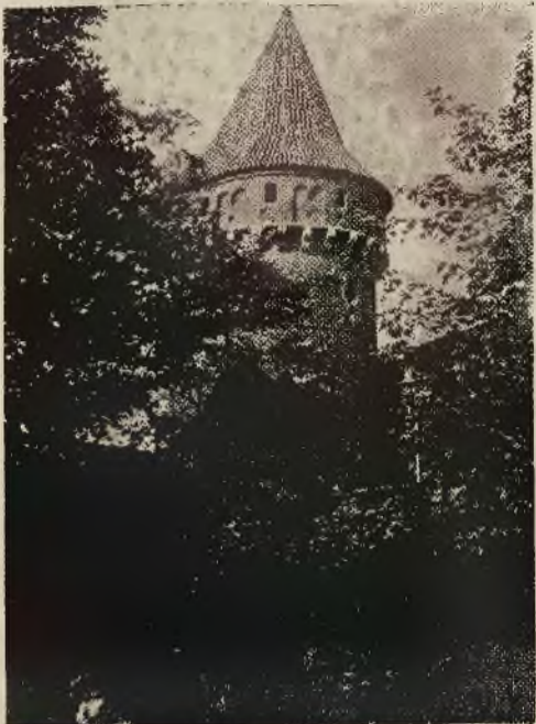
Baszta stolarzy i powroźników od strony plant
