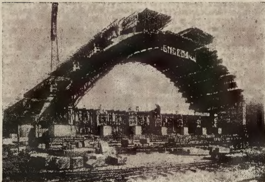
Centralna hala wystawowa w budowie
