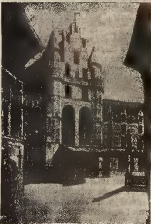
Zakątek starej Brukseli.
