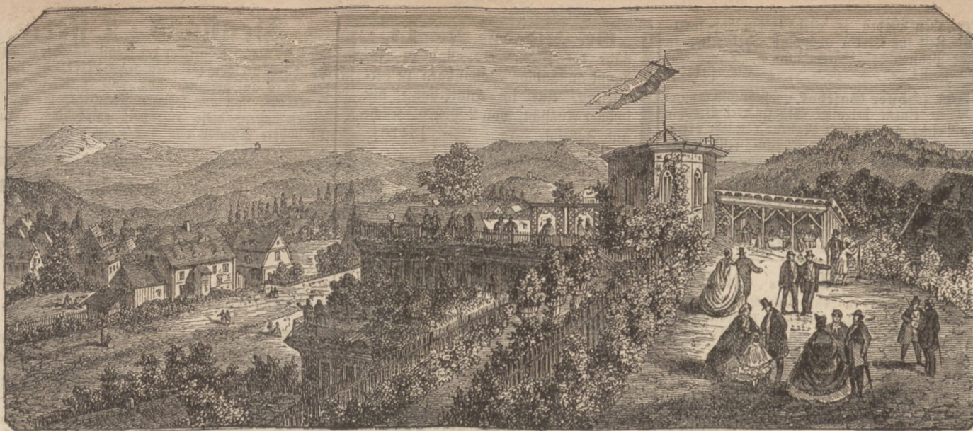
Ansicht der mit Holz-Cement gedeckten Weinhalle des Carl Samuel Häusler, Erfinder des Holz-Cements in Hirschberg in Schlesien.
