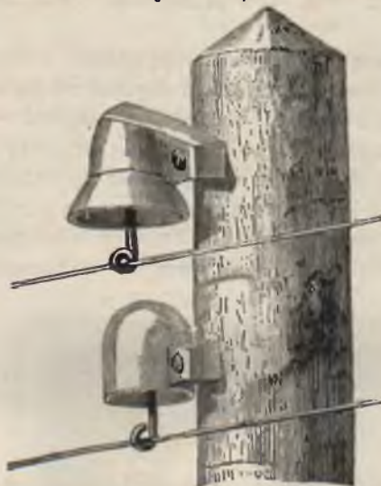
Fig. 157. Słup telegraficzny i dzwonek odosobniający porcelanowy.
