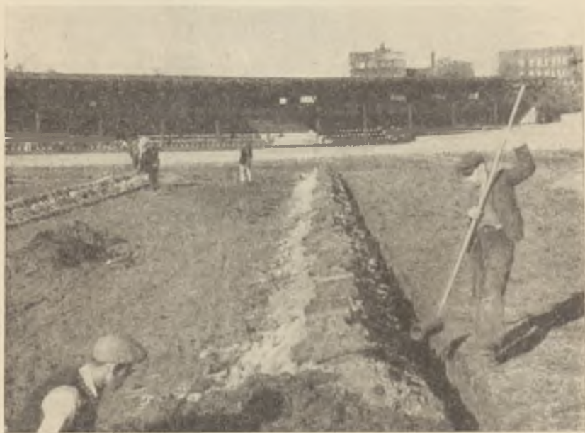
Odbudowa boiska K. S. „Cracovia“. Zakładanie drenów (sączków). Październik 1945.
