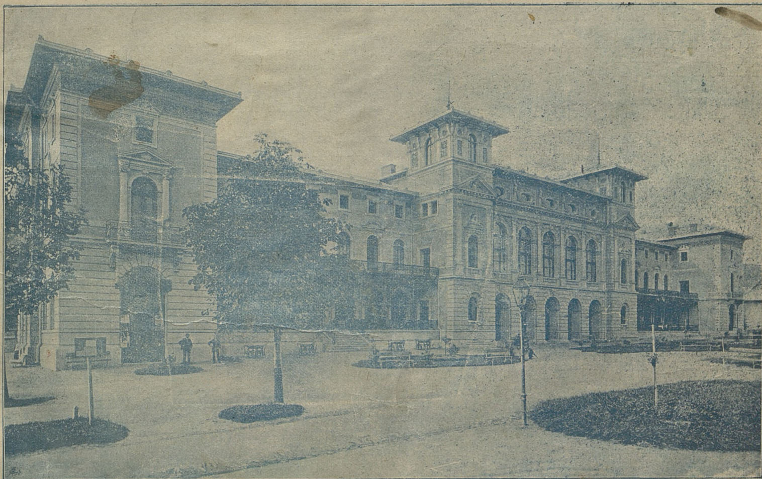
Widok ogólny domu zdrojowego w Krynicy.
