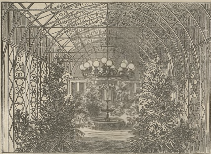
Wnętrze domu palmowego w Reinerz.
