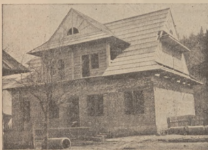
Dom Ludowy w Łapszach Niżnych w obecnym stadium budowy.
