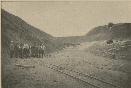
Budowa strzelnicy w Chropaczowie. Roboty ziemne wykonuje miejscowa grupa Związku Powstańców Śląskich bezinteresownie pracą rąk swych członków. Pierwszy od lewej stoi prezes grupy p. Bartodziej, który rzucił myśl budowy strzelnicy. Zawody lekkoatletyczne Związku Powstańców Śl. pow. świętochłowice.
