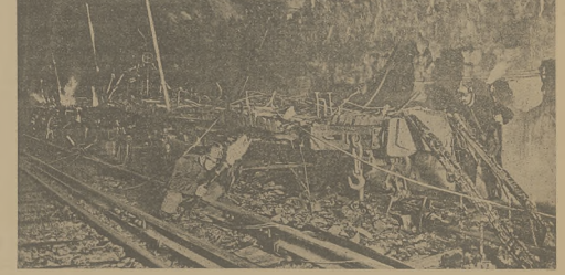
Widok spalonego pociągu w tunelu. (Katastrofa pożaru wywołała tak zw. „krótkie splecie” przewoźni elektrycznej, skutkiem czego zapali się jeden wagon. Pożar ogarnął rychło cały pociąg — a dym gęsty odział w ciemności mieszczących pasażerów dymnego pociągu, który nadszedł z przełaznej strony, a którego pasażerowie zawczasu opuścić nie chcieli.)
