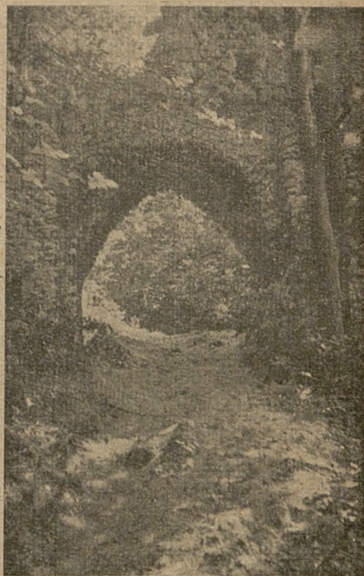
Smoleń — brama wjazdowa na zamek.
