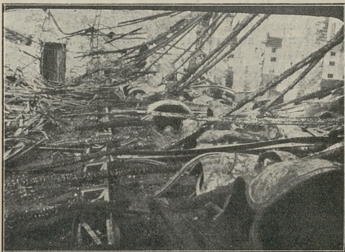
Ogólny widok spalonego garażu.
