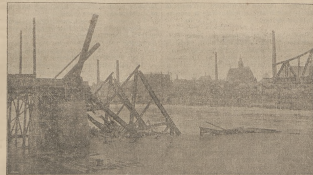
Widok ogólny III mostu na Wiśle za przerwaniem w aparacie (Fotogr. redakcyjnym „Nowin“).
