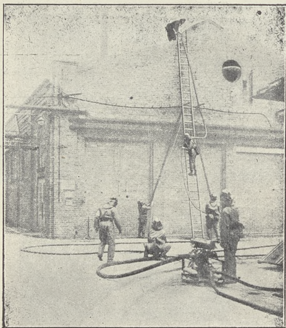
Ryc. 13. Wspinanie się straży na płonący dach.
